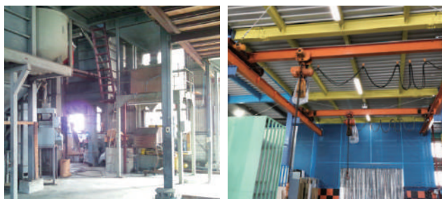
事務所兼工場の改修前(左)と改修後(右)。
